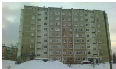
Рис. 1. Дом по ул. Космонавтов, 4
